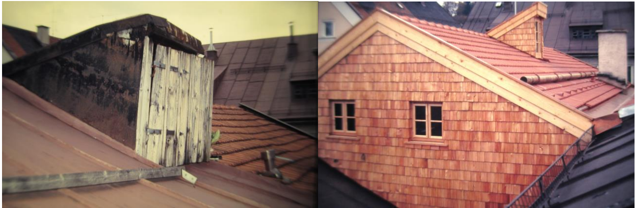
Dachausstieg alt und neu nach der Sanierung des Dachstuhls
