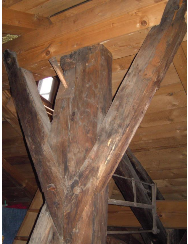
Teile des alten Dachstuhls sind bis heute erhalten, hier Kopfband
