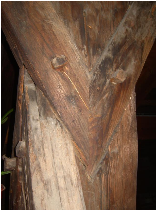
Teile des alten Dachstuhls sind bis heute erhalten, hier Kopfband
